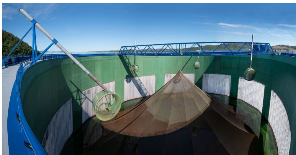
Figur 4-3 Strømsetterne montert på gangbane og bro
