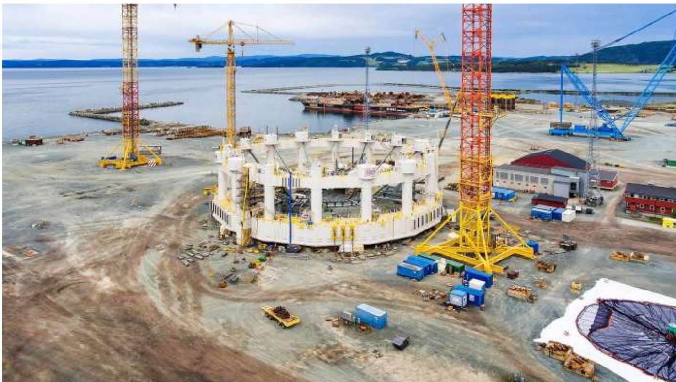
Figur 10: Utrusting av merd ved verft på Verdal.
